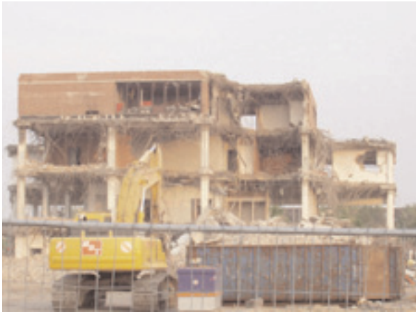
Afb. 1.3 Sloop van gebouw
