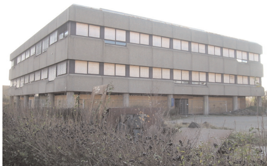
Afb. 1.2 Exterieur van verouderd gebouw
